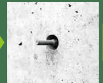
Mコンの取り付け完了
