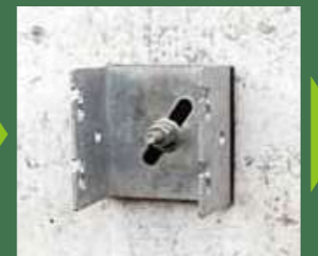
ナンパチャンネルの取り付け
