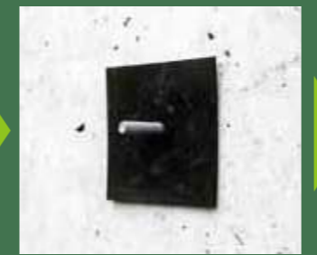
Mコンにゴムマットを取り付け
