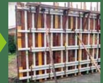
コンクリート打ち
